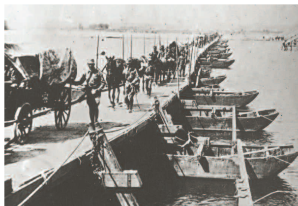
Ofensywa majowa. Przeprawa oddziału sanitarnego I Brygady Legionów mostem pontonowym przez Wisłę po bitwie pod Józefowem FOT. NARODOWE ARCHIWUM CYFROWE (WWW.NAC.GOV.PL)
